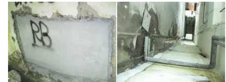
Thi công Vincom Tower
