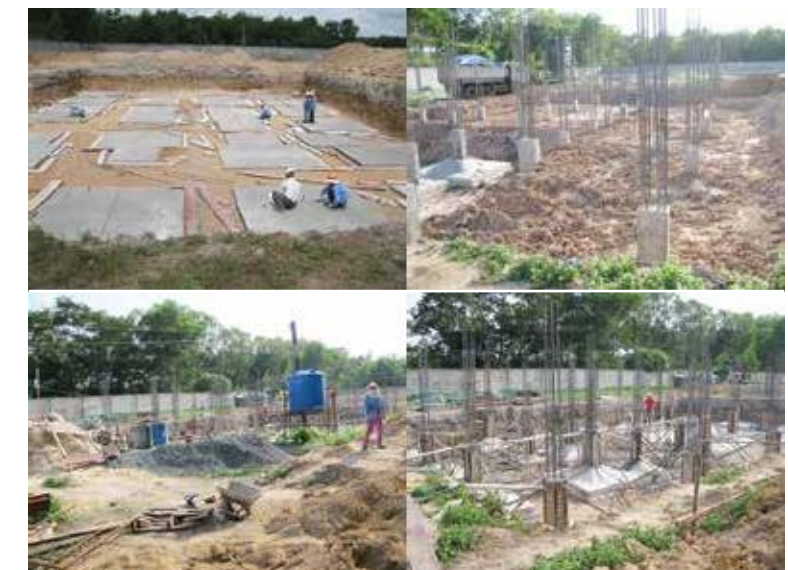
Thi công Bình Phước
