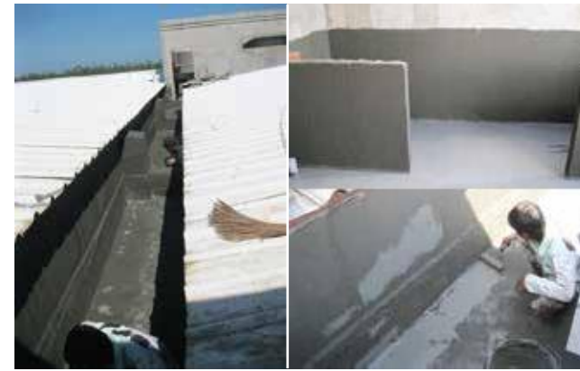
Chống thấm mặt cầu
